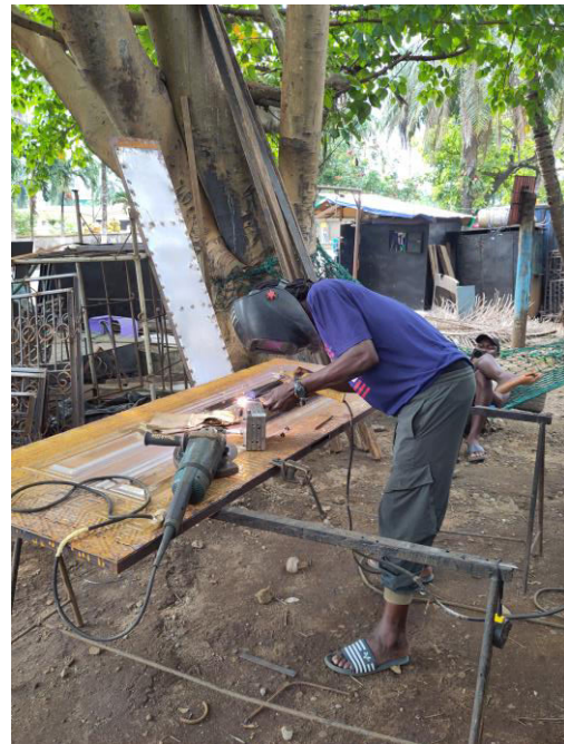
Der Schweißer bei der Arbeit.
