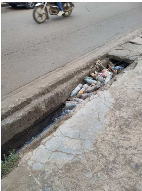
Leichtsinnig weggeworfene PET-Flaschen verstopfen die offene Kanalisation, was in der Regenzeit immer wieder zu gefährlichen Überschwemmungen führt.
